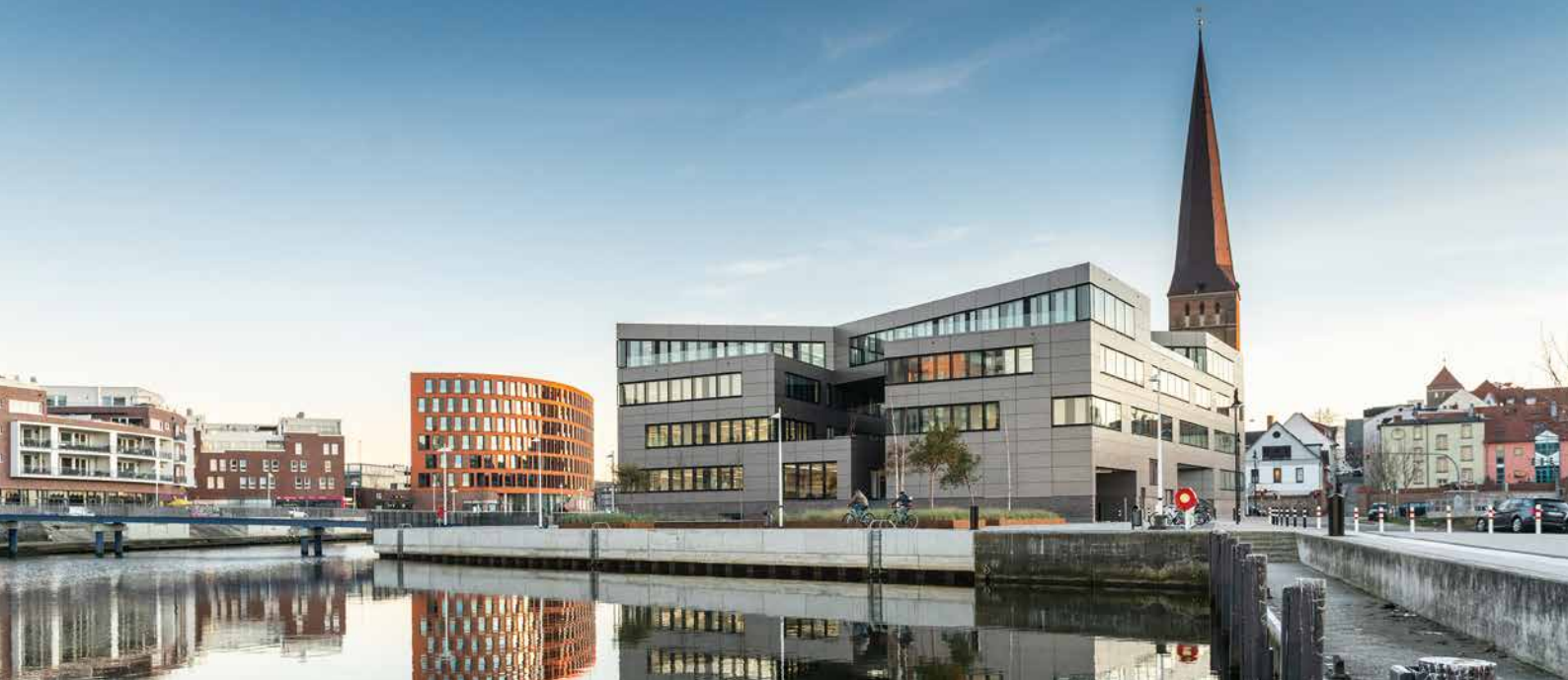
Neubau des Firmensitzes von Centogene auf der Silohalbinsel im Stadthafen Rostock | © Pinkau
