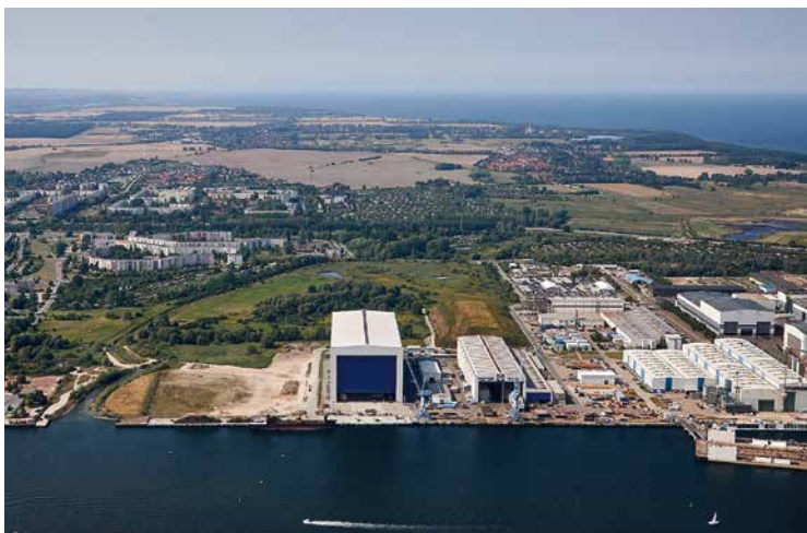
Die NEPTUN WERFT investierte am Standort in einen Hallenneubau mit einer Fläche von rund 13.000 m 2 , der eine lichte Breite von 60 m und eine Gesamthöhe von 58 m hat. | © nordlicht
