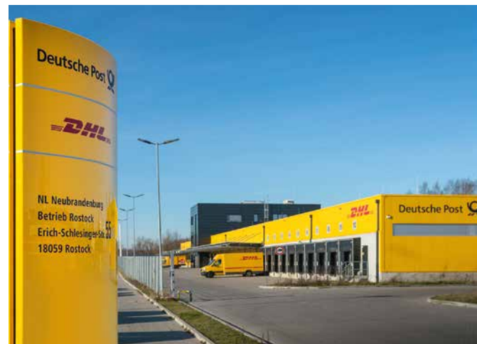
Die Deutsche Post errichtete in der Südstadt unweit vom Hauptbahnhof ein neues Postverteilzentrum. | © Pinkau
